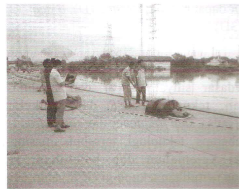
Gambar 3.1 : Lokasi Scanning GPR (Jl. RE Martadinata) Jakarta Utara
